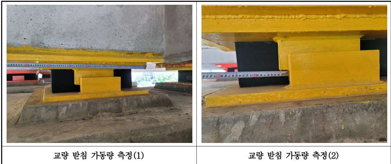
【사진 15.3.16】 교량받침 이동량 측정
