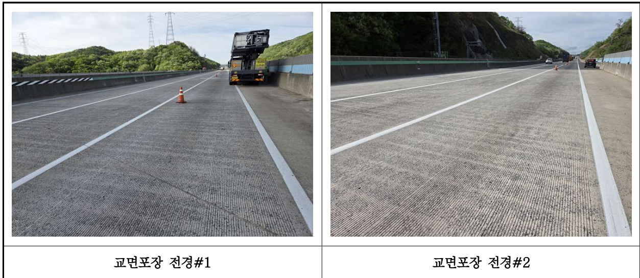
【사진 15.3.20】 교면포장 전경
