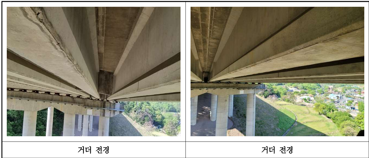
【사진 15.3.4】 거더 전경
