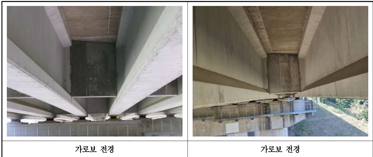
【사진 15.3.6】 가로보 전경
