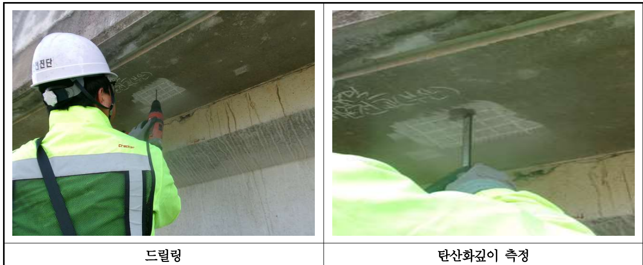
【사진 15.4.3】 탄산화 깊이 측정 현장사진
