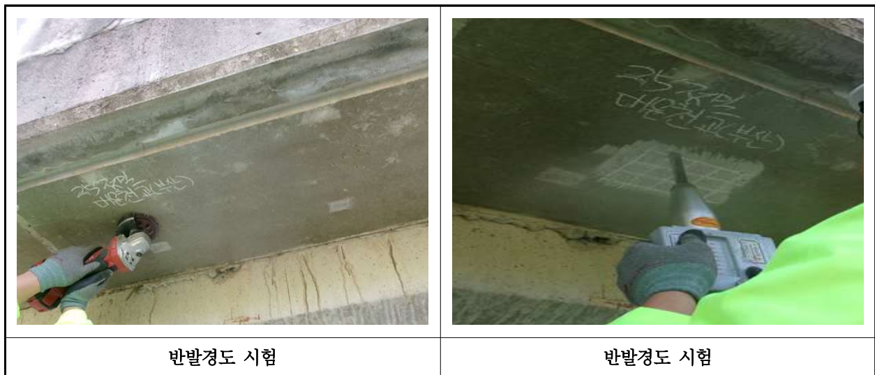
【사진 15.4.2】 반발경도시험 현장사진
