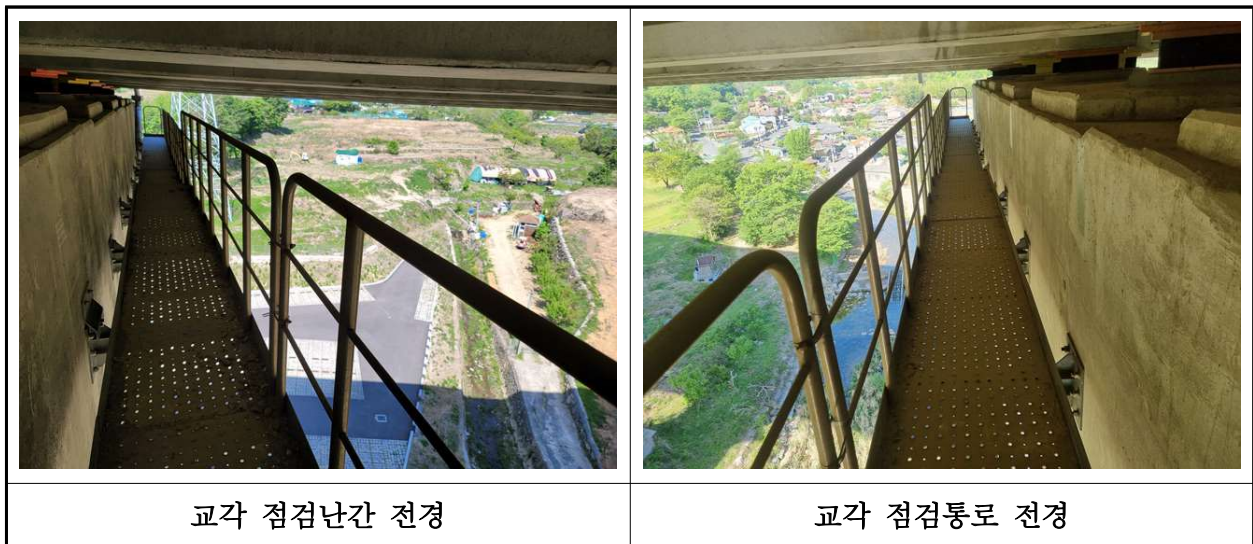
【사진 15.3.26】 교량 점검시설 전경
