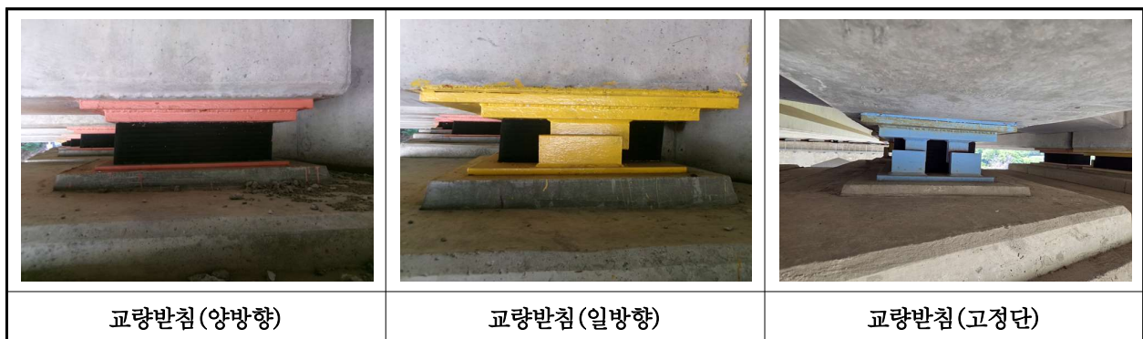
【사진 15.3.13】 교량받침 전경
