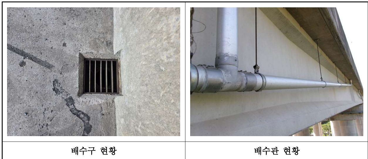
【사진 15.3.22】 배수시설 전경
